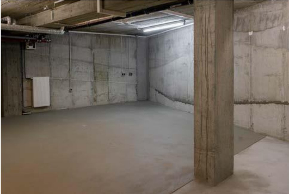
Keller mit Zugang zu Lagerräumen
