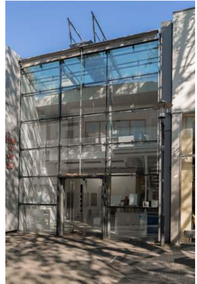
Blick von Außen
