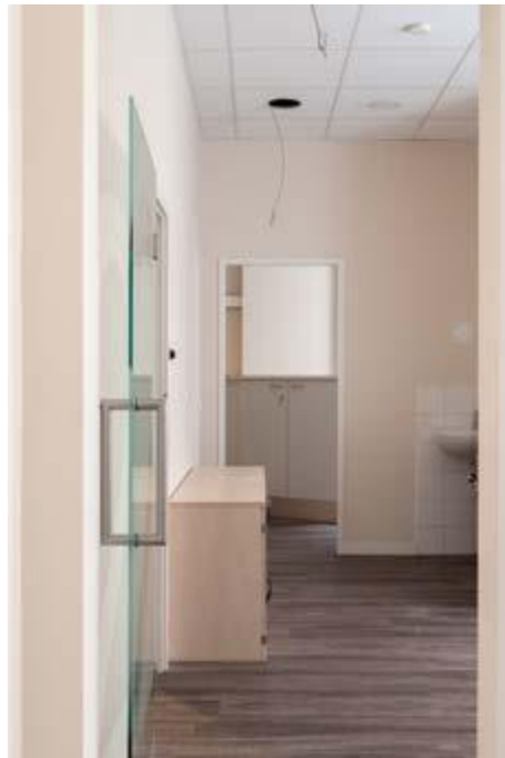
Raum 2, Durchgangstür nach hinten
