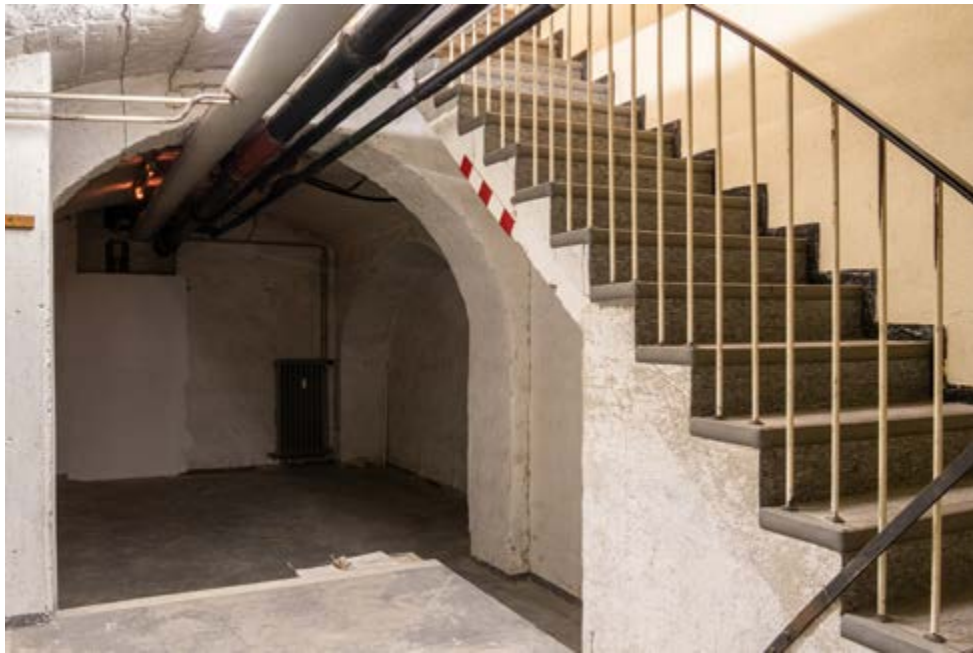
Keller, Zugang über die Treppe
