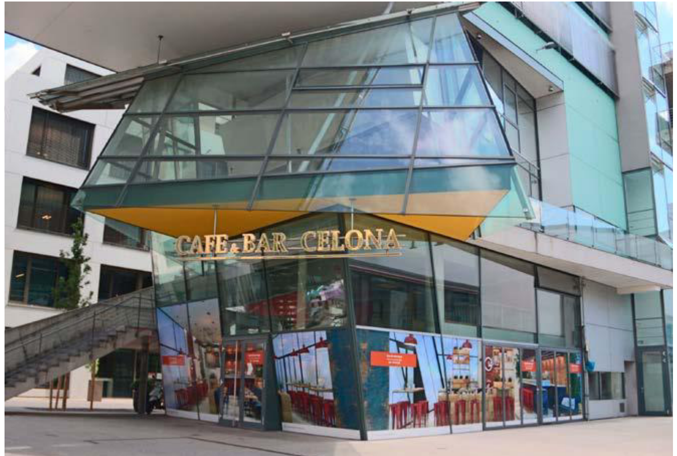
Blick von Außen
